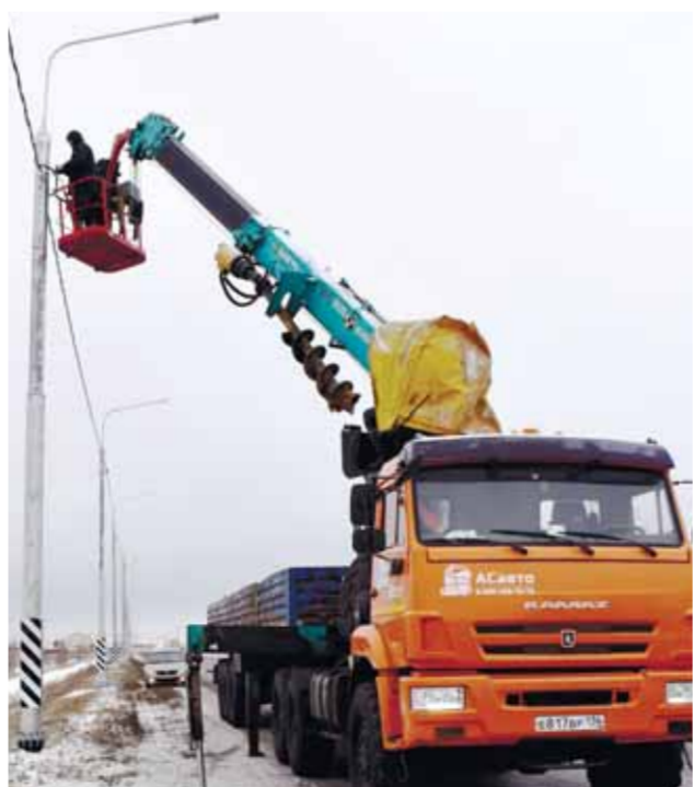
Идет процесс монтажа освещения — установка энергосберегающих светильников
